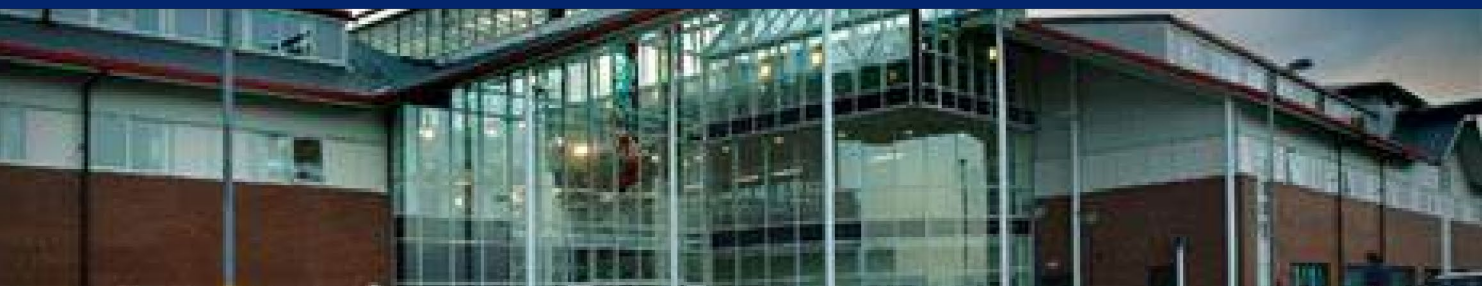
Ysbyty Castell-nedd Port Talbot
